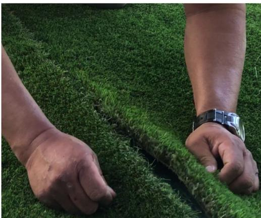
Coloque el césped artificial sobre la banda de unión y pénelo uniendo ambos lados.
